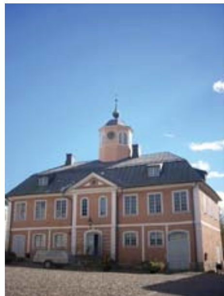
Ратуша г. Порвоо. Ныне Исторический музей
